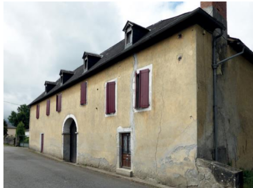
Photo 17 : Maison grange caractéristique avec une longue façade à l'alignement sur rue, coiffée d'une toiture homogène sur la commune d'Herrère - Pays d'Art et d'Histoire Pyrénées Béarnaises
