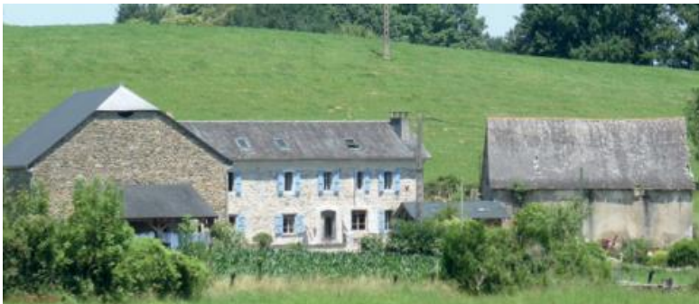
Photo 16 : Ferme à cour spacieuse isolée dans la campagne, présentant plusieurs corps de bâtiment séparés sur la commune de Lurbe-Saint-Christau - Pays d'Art et d'Histoire Pyrénées Béarnaises
