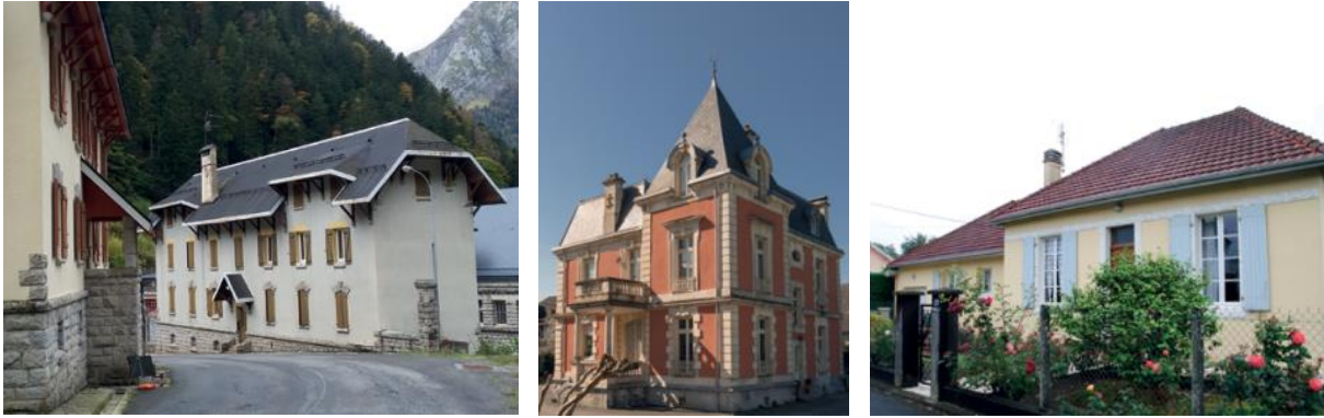
Photo 21 : A gauche, logements groupés des ouvriers de la SHEM à Laruns. Au centre, villa patronale inspirée d'un castel à Oloron-Ste-Marie. A droite, maisonnette ouvrière de la Cité Bedat à Goès-Oloron-Ste-Marie. - Pays d'Art et d'Histoire Pyrénées Béarnaises
