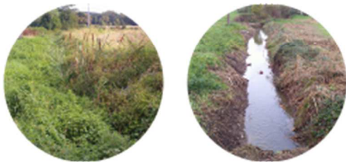
Réouverture de milieux Débroussaillage et gestion de la végétation aquatique et de sédiments fins
