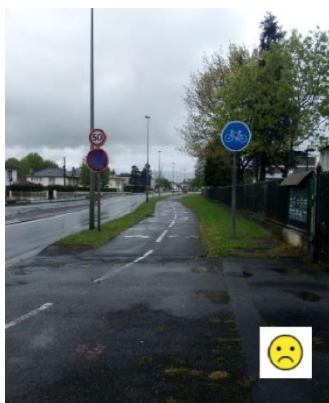
Piste cyclable mal entretenue conflit avec piétons Double-sens-cyclable non signalé sur une voie à 30 km/h
