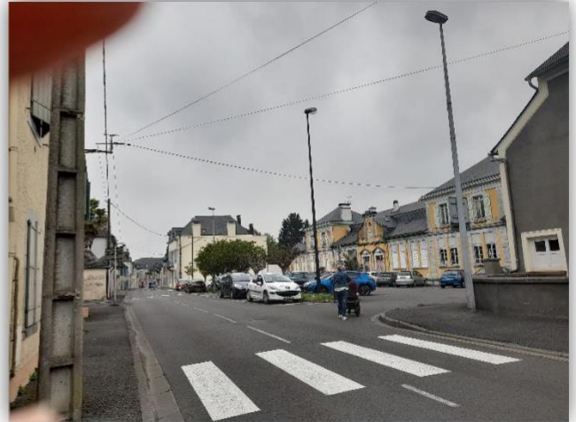
Figure 3 Accessibilité piétons sur trottoir
