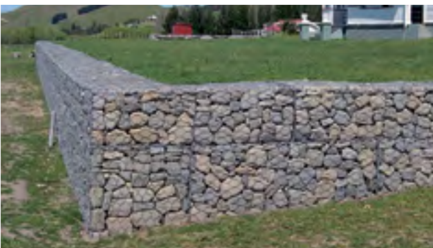
Exemple de murs gabions en soutènement.
