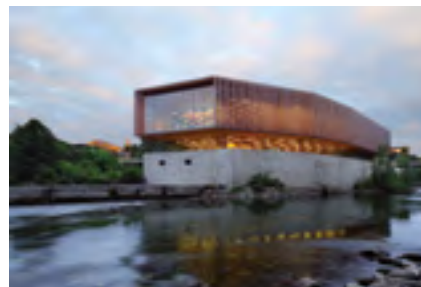
Médiathèque des Gaves, Pascale Guédot Architecte.
