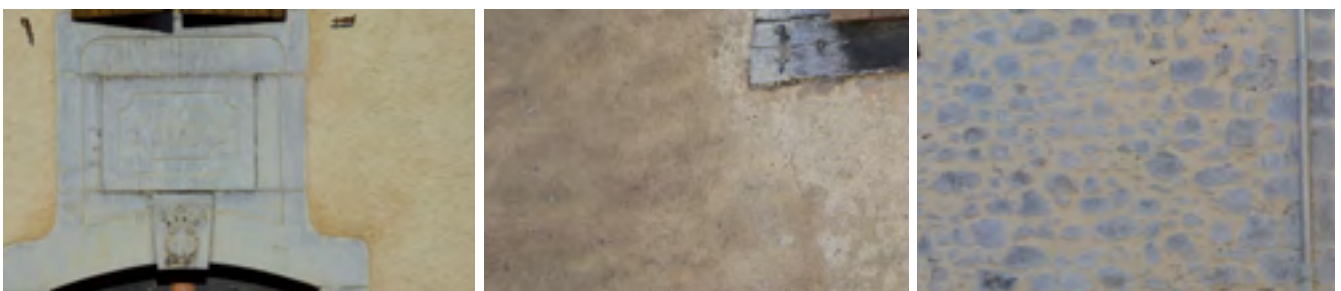
Badigeon coloré au pigments minéraux, finition talochée aux sables locaux et enduit coloré à pierre vue.
